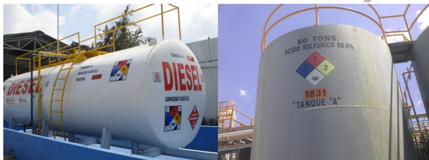
Figura 5. Ejemplo de rotulado de tanques estacionarios
