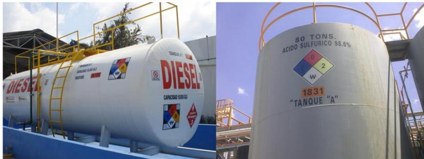
Figura 4. Ejemplo de rotulado de tanques estacionarios
