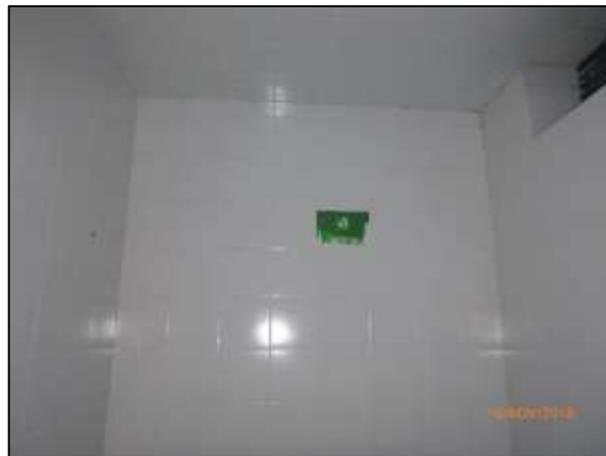
Ilustración 154. Señalización no permite limpieza y desinfección.
