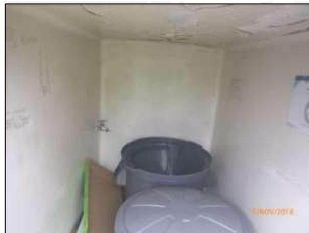
Ilustración 175. Techo no permite limpieza y desinfección
