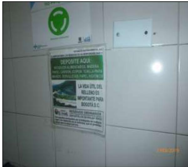
Ilustración 116. Señalización que no permite limpieza y desinfección.
