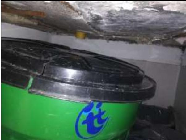
Ilustración 176. Techo no permite limpieza y desinfección.
