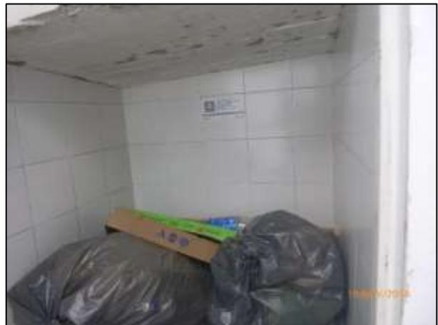
Ilustración 158. Techo no permite limpieza y desinfección.
