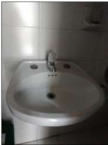
Ilustración 15. Grifo sin sistema ahorrador U.S. Candelaria III.
