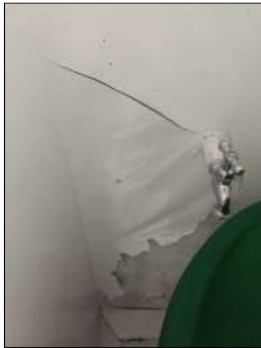
Ilustración 155. Pintura de la pared levantada U.S. Limonar
