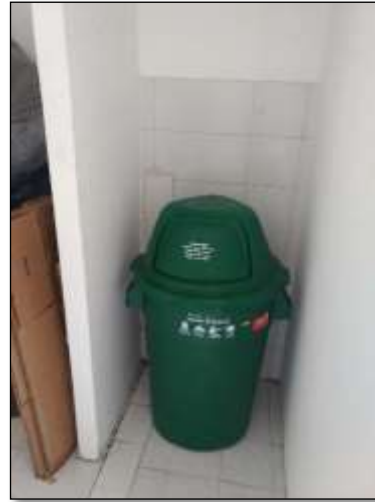
Ilustración 154. Paredes sin media caña U.S Casa de Teja.
