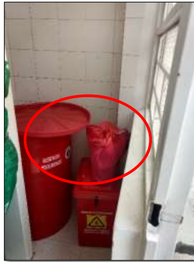
Ilustración 168. Residuos químicos y biosanitarios sin separación física U.S. Potosí
