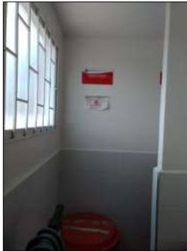
Ilustración 172. residuos químicos y biosanitarios sin separación física U.S. Jerusalén.
