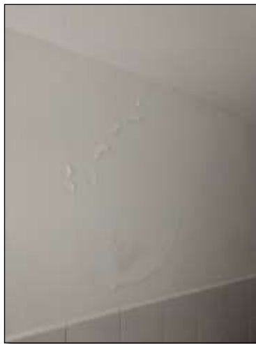
Ilustración 178. Pintura levantada U.S. Sierra Morena.
