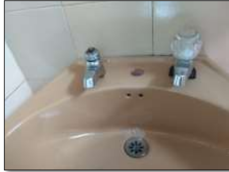
Ilustración 10. Grifo sin sistema ahorrador U.S Casa de Teja
