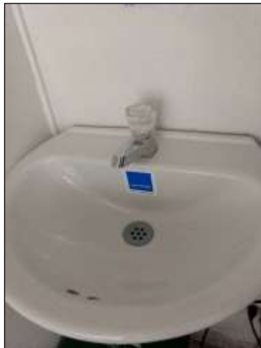
Ilustración 7. Grifo sin sistema Ahorrador U.S. La Estrella
