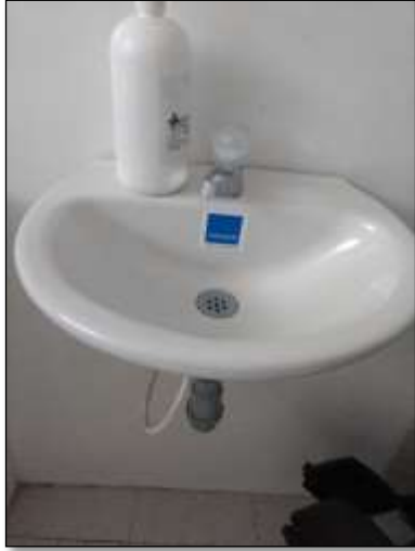
Ilustración 9. Grifo sin sistema ahorrador U.S Casa de Teja
