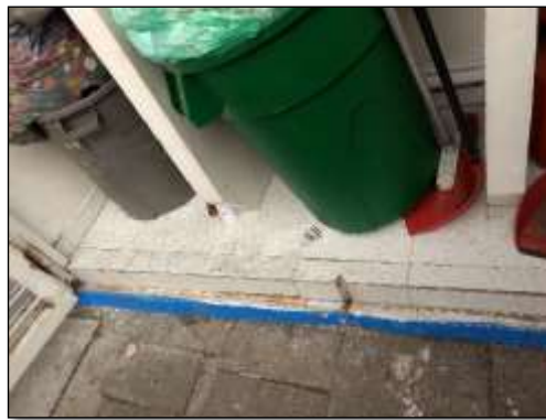
Ilustración 182. Paredes sin media caña U.S Ismael Perdomo.
