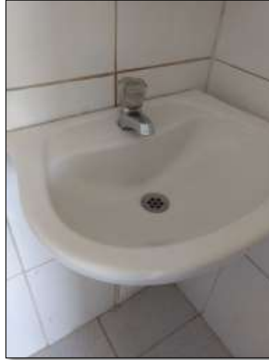
Ilustración 14. Grifos sin sistema ahorrador U.S. Candelaria II
