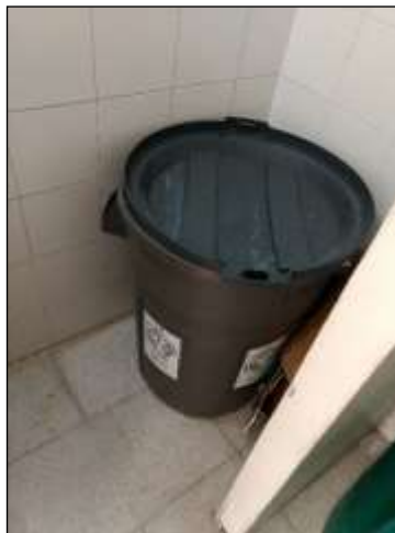
Ilustración 175. Paredes sin media caña U.S. Manuela Beltrán.
