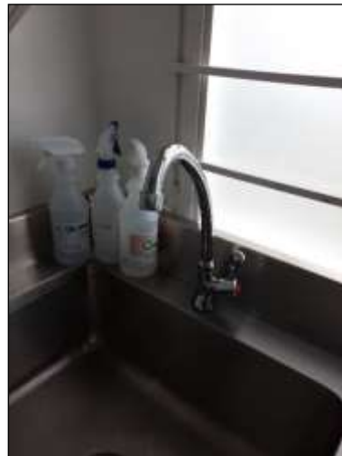
Ilustración 4. Grifo sin sistema ahorrador U.S. Pasquilla
