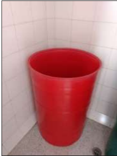
Ilustración 122. Almacenamiento intermedio sin media caña en sus paredes U.S. Vista Hermosa.
