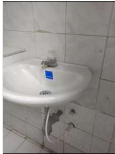
Ilustración 16. Grifo sin sistema ahorrador U.S. Potosí.
