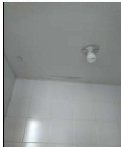
Ilustración 133. Pintura de techo levantado U.S. Nazareth
