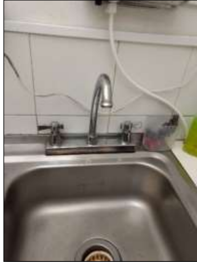
Ilustración 18.. Grifos sin sistema Ahorrador U.S. Manuela Beltrán.
