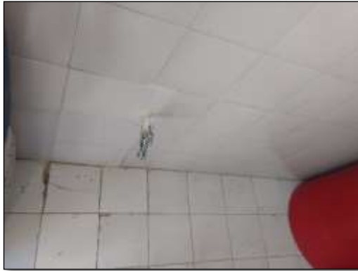
Ilustración 157. Paredes sin media caña U.S San Francisco.
