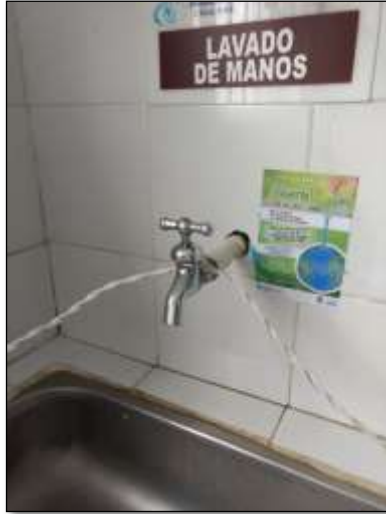
Ilustración 5. Grifo para lavado de manos sin ahorrador U.S Destino.
