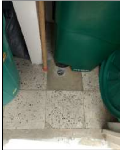
Ilustración 144. Paredes sin media caña U.S Paraíso
