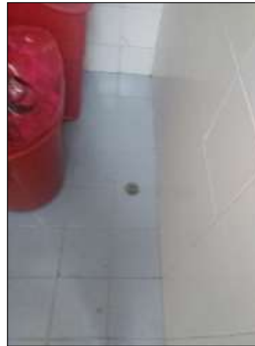
Ilustración 166. Paredes sin media caña U.S Candelaria II
