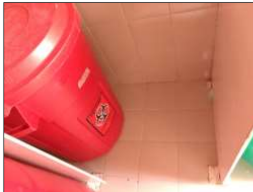
Ilustración 136. Paredes sin media caña U.S. Mochuelo.
