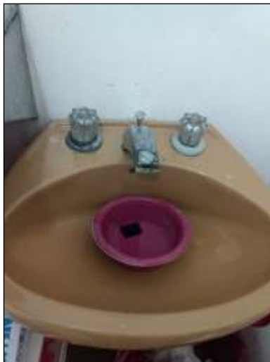
Ilustración 19. Grifo sin sistema ahorrador U.S. Sierra Morena.
