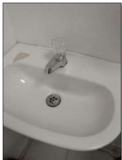
Ilustración 20. Grifo sin sistema ahorrador Ismael Perdomo
