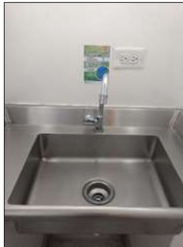
Ilustración 8. Grifo sin sistema ahorrador U.S Vista Hermosa.
