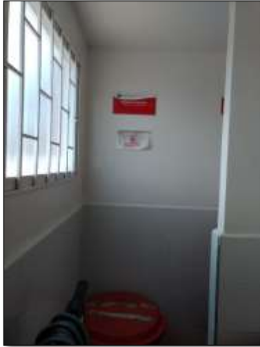
Ilustración 170. Señalización que no permite limpieza y desinfección U.S. Jerusalén
