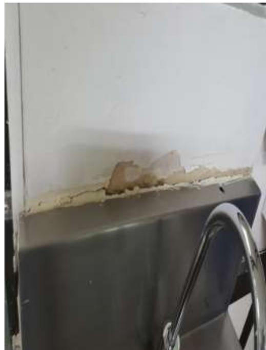
Se observa deterioro en general de la pintura en la unidad de cuidado intensivo, no hay continuidad en la media caña, no permitiendo una fácil limpieza y desinfección
