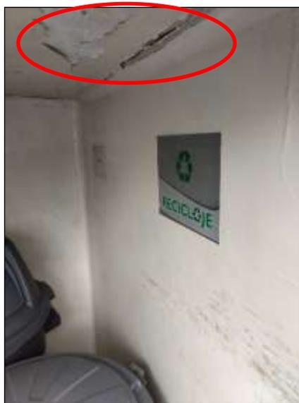
**Ilustración 140. techo con desgaste, no permite limpieza adecuada U.S.S. Administrativa II**
