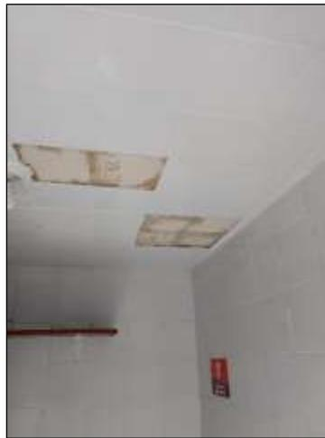
**Ilustración 180. Techo sin baldosín no permite limpieza y desinfección U.S.S. La Reforma**
