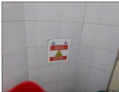
**Ilustración 119. Señalización que no permite limpieza y desinfección.**
