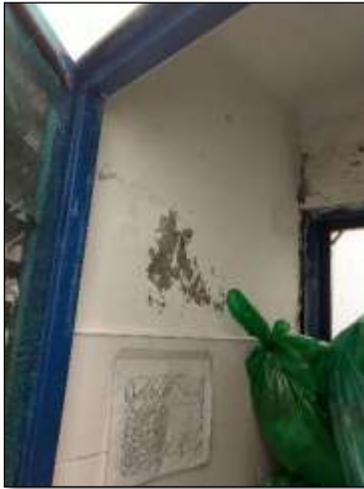
**Ilustración 150. Paredes deterioradas que no permiten fácil limpieza y desinfección U.S.S. El Carmen**
