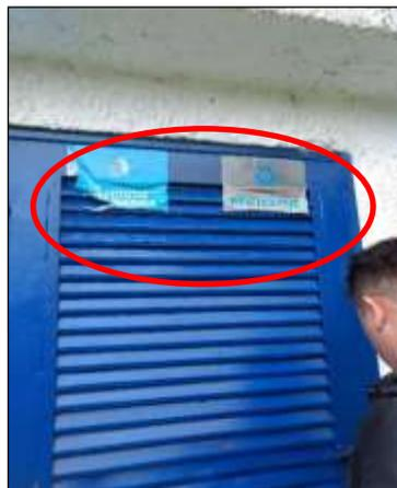
**Ilustración 185. Señalización que no permite limpieza y desinfección U.S.S. Arrayanes.**
