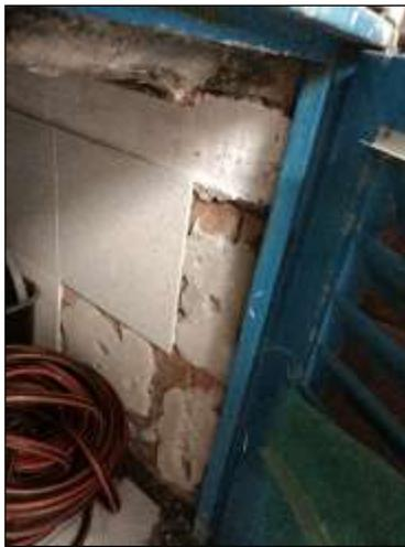
**Ilustración 136. Paredes deterioradas, no permiten limpieza y desinfección U.S.S. Isla del Sol**
