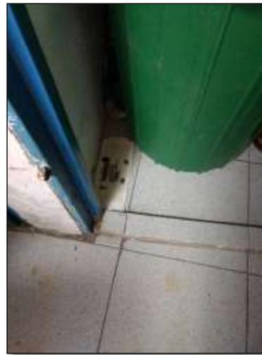
**Ilustración 137. Paredes sin media caña U.S.S. Isla del Sol**
