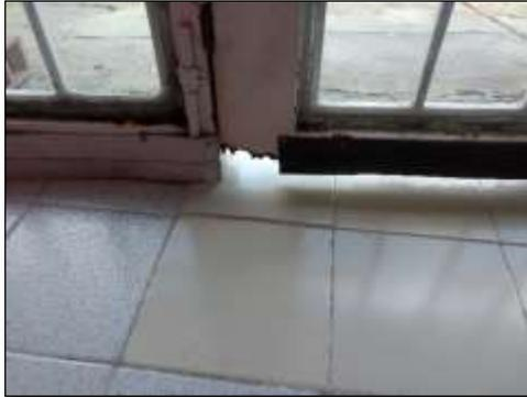
**Ilustración 124. Puerta con deterioro que permite ingreso de rastreros U.S.S. Abraham Líncon**
