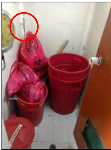
**Ilustración 141. desgaste en las paredes impide adecuada limpieza y desinfección**
