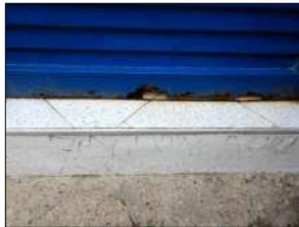
**Ilustración 158. Puertas con daño que posibilita el ingreso de roedores. U.S.S. Yomasa.**
