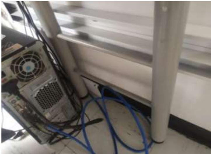
**RECOMENDACIÓN:** Ajustar y tapar las canaletas correspondientes, con el fin de evitar futuros deterioros en el cableado.
