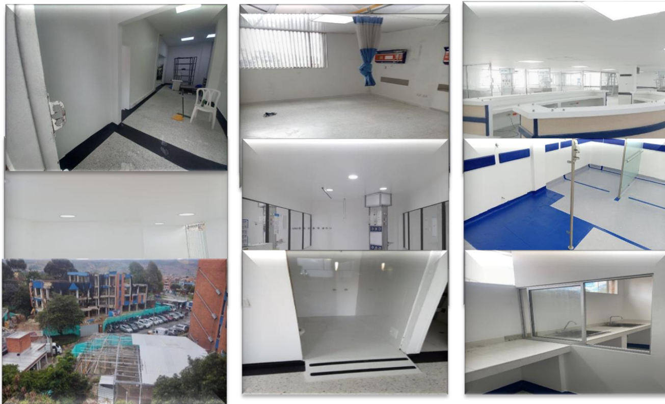
Ilustración No. 51: Adecuaciones Hospital Tunal
