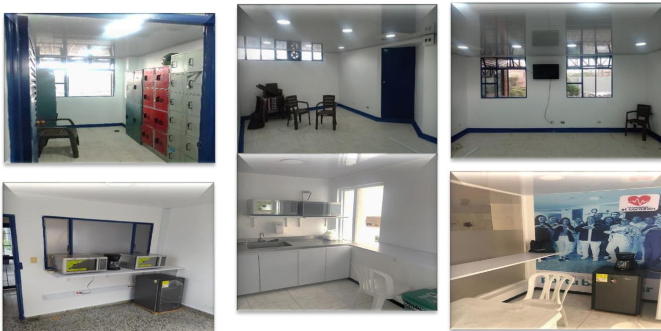
Ilustración 58. Registro fotográfico: Adecuaciones de mantenimiento áreas de bienestar
