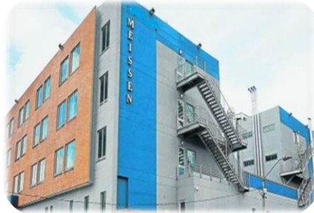
Adecuación y dotación torre 2 Meissen
