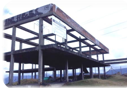
Construcción y Dotación CAPS Manuela Beltrán
