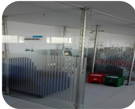
Mantenimiento del área hospitalaria de las Unidades Tunal, Meissen
