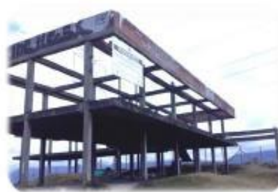
Construcción y Dotación CAPS Manuela Beltrán
