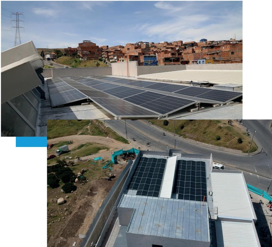
Con 118 paneles solares instalados, la Subred Sur viene implementando sistemas de energía solar en los centros de salud del sur de Bogotá, **reduciendo así la emisión de gases de efecto invernadero mediante el abastecimiento con energías limpias.**
