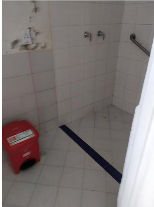
Antideslizante en mal estado, sin desnivel para el descenso del agua, lo que ocasiona el represamiento y la generación de riesgos de caída.
