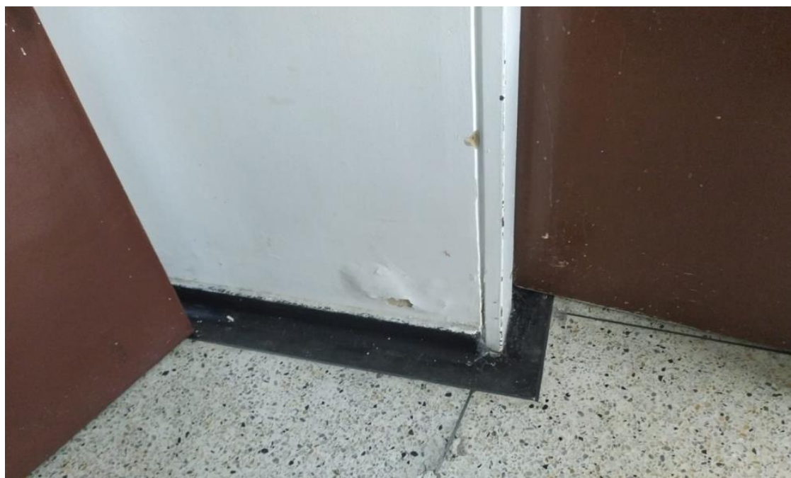
Estado de pisos y paredes consultorio de enfermería – gestantes
