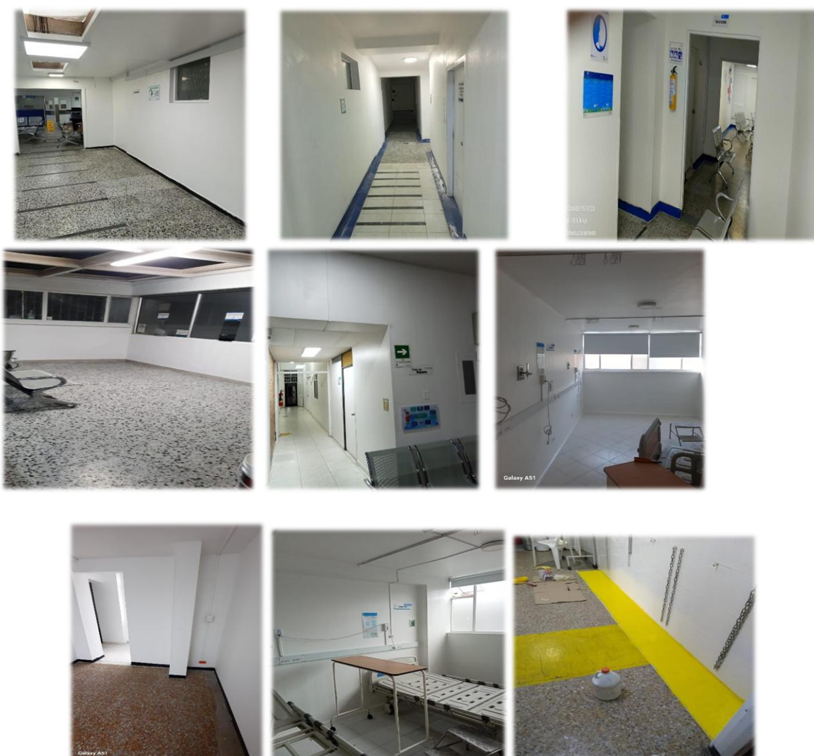
Ilustración 41 Adecuaciones Unidades de Tunjuelito
