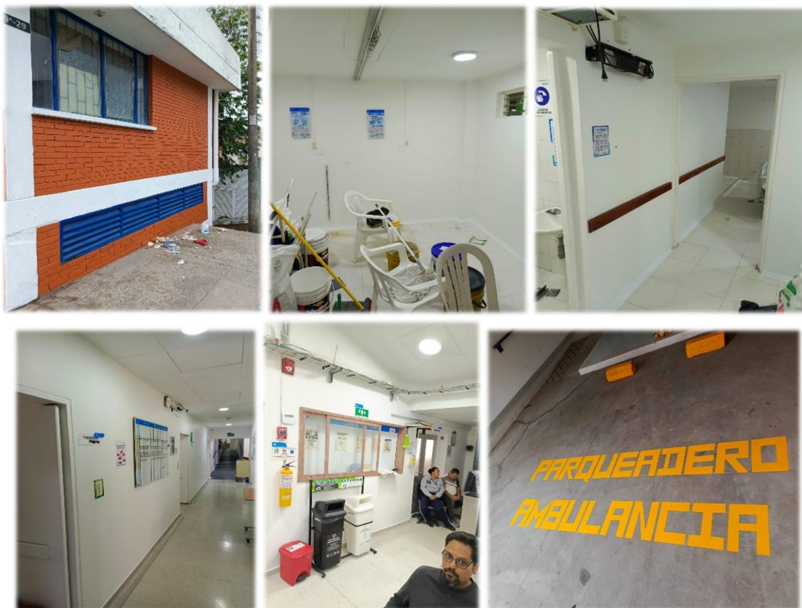
Ilustración 42 Adecuaciones Unidades de Usme
