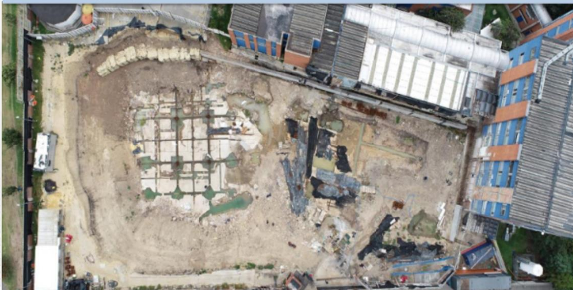
ESTADO DE OBRA (ANTES) - SEMANA 1
