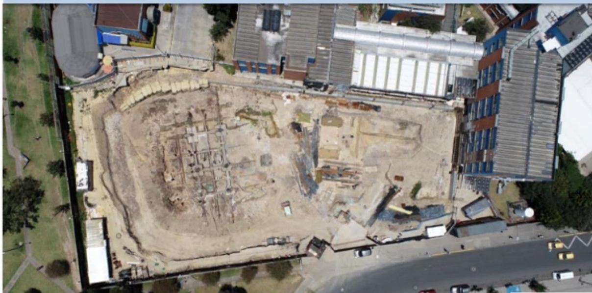
ESTADO DE OBRA (DESPUES) - SEMANA 7
