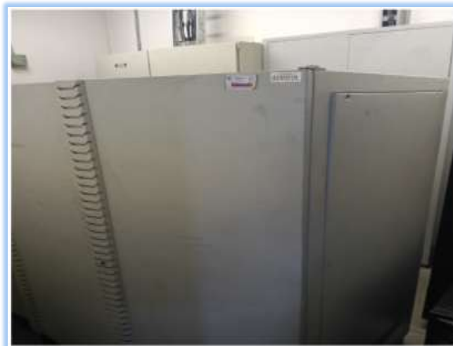
Imagen 06. Equipos de comunicación y computación sede Vista hermosa – febrero 19 2026
