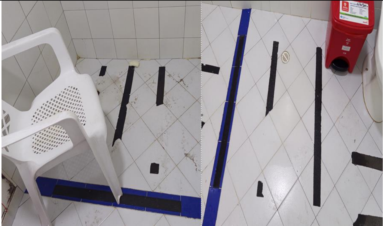
Baños de la habitaciones del piso 6 sur – UMHES Meissen
