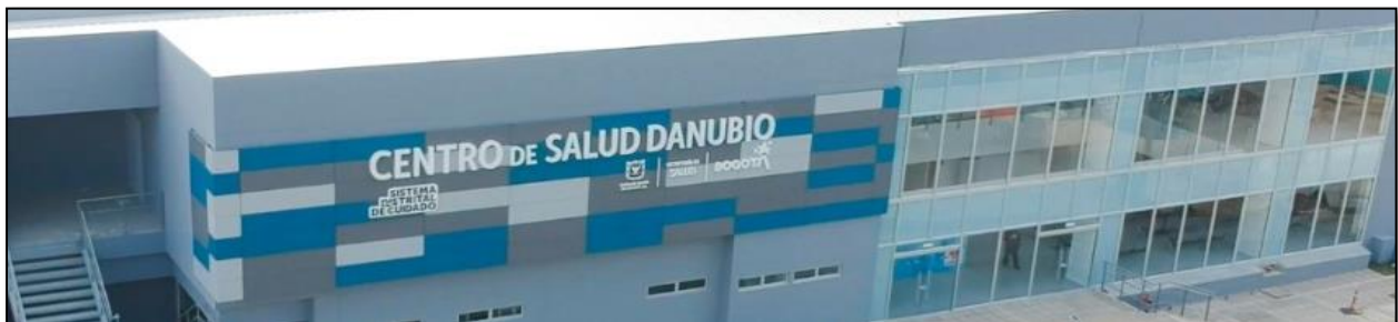
Imagen 10. Centro de Salud Danubio . Fuente: Registro Fotográfico Oficina Asesora de Comunicaciones – Oficina de Control Interno - Subred Sur E.S.E.
